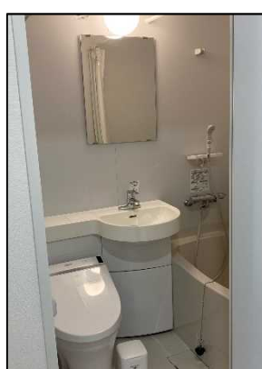
<浴室・トイレ>
